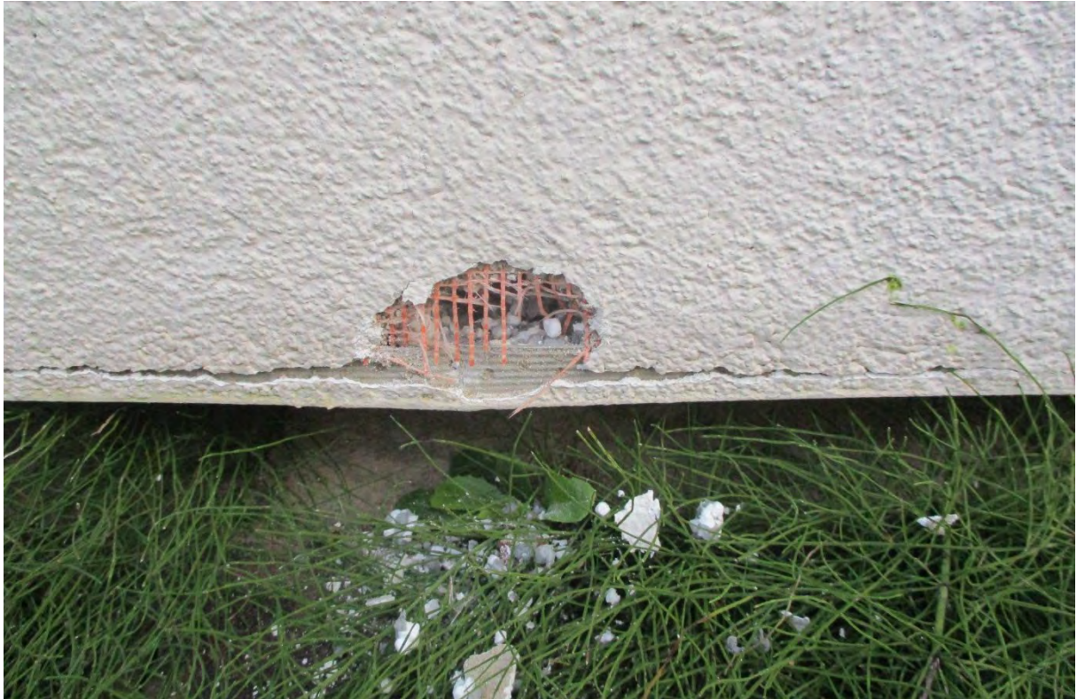
Foto 7: Styropordämmung Aufzug
