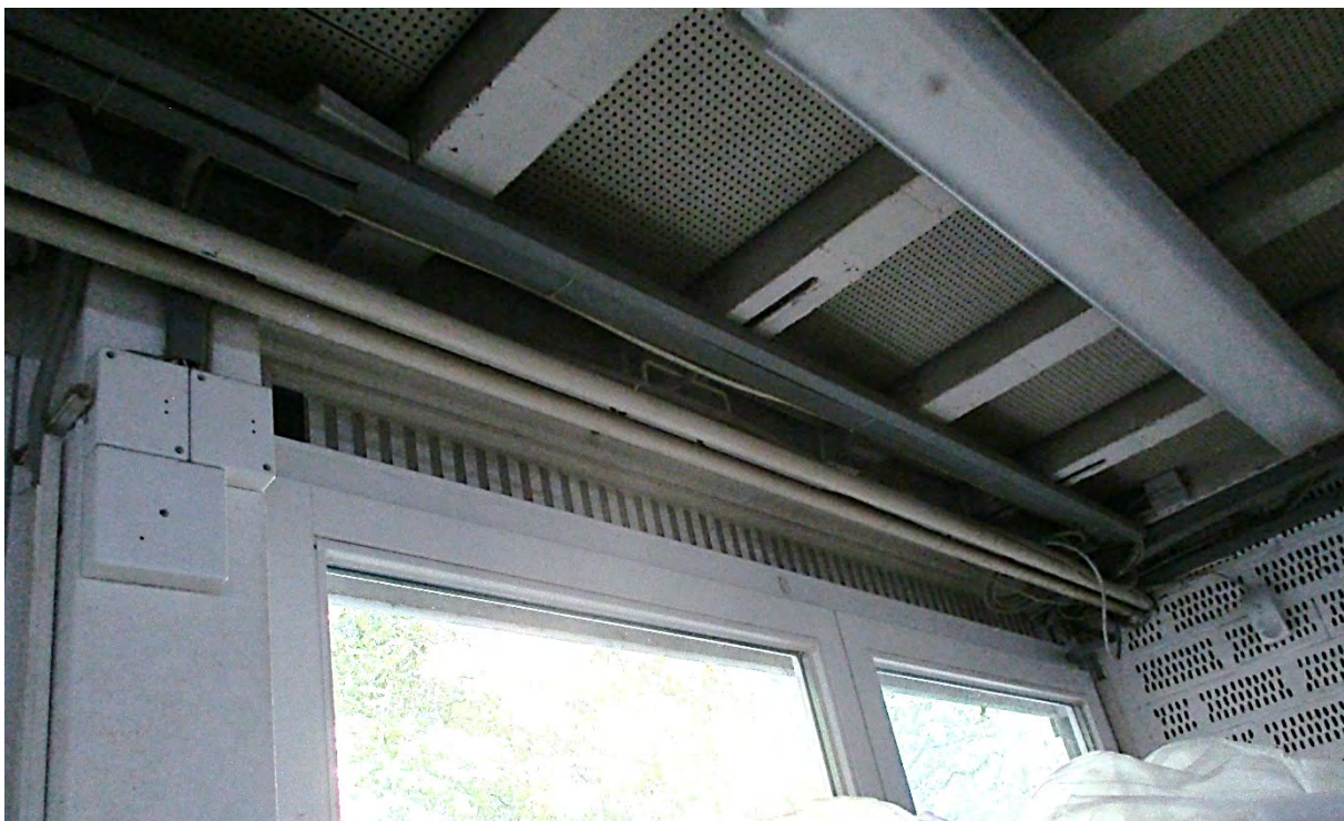
Foto 6: Deckenplatten mit KMF
