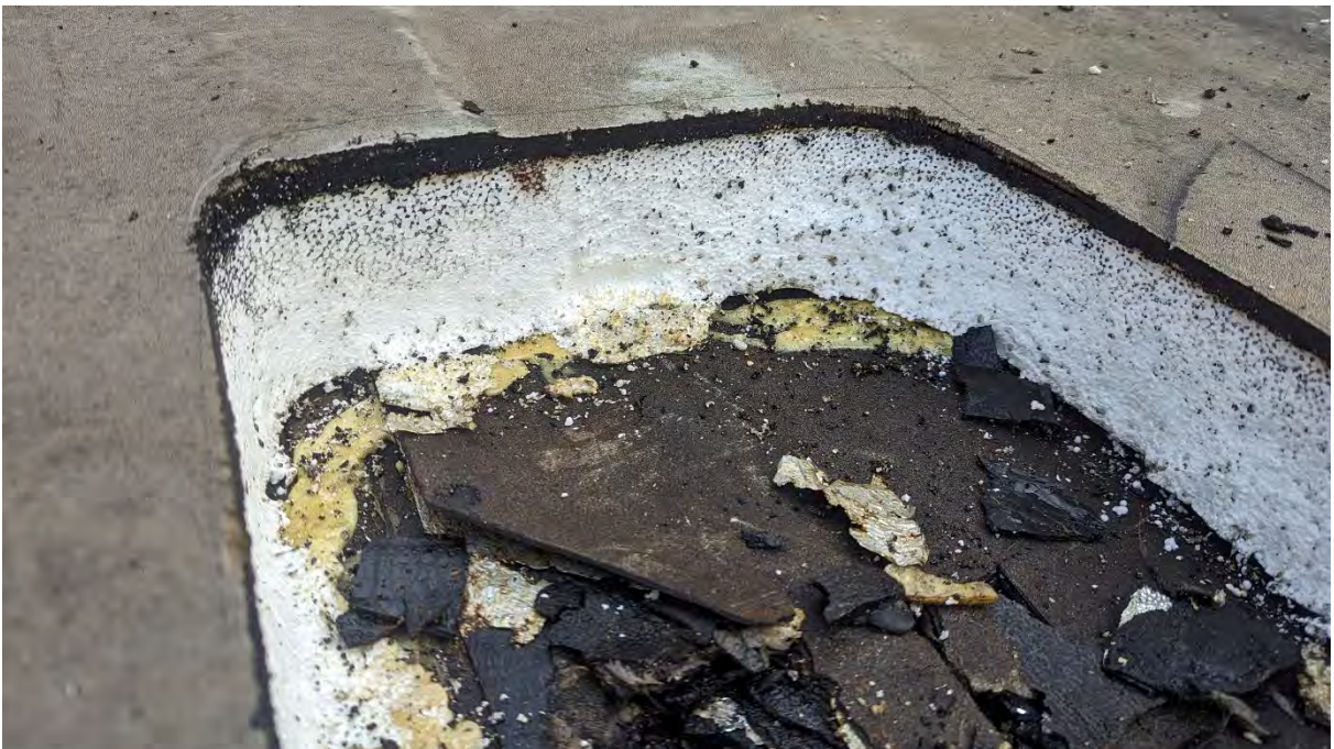
Foto 4: obere Dachbahn, Styropordämmung und untere asbesthaltige Dampfsperre
