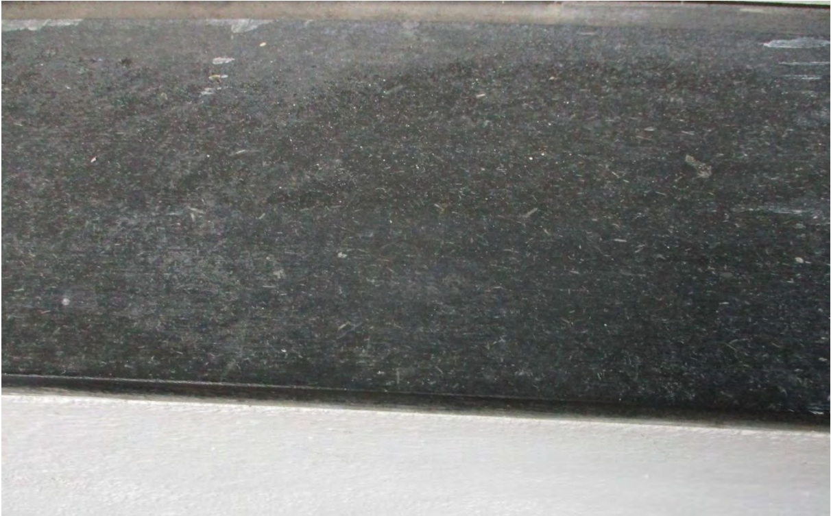
Foto 3: Asbestzement Fensterbank
